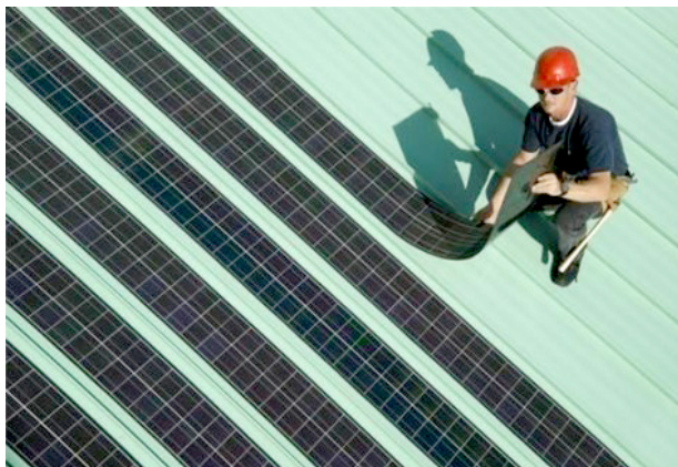
Рис. 6. Ячейка CIGS на гибкой пластиковой подложке [24] Fig. 6. CIGS cell on a flexible plastic substrate [24]
