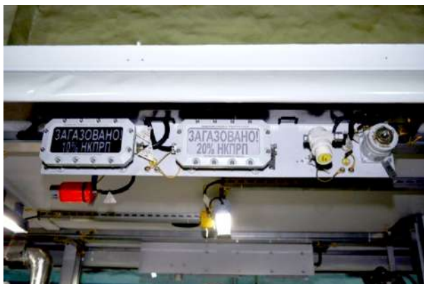
Рис. 5. Система пожарной сигнализации МКБ Fig. 5. Mobile compressor unit (fire alarm system)
