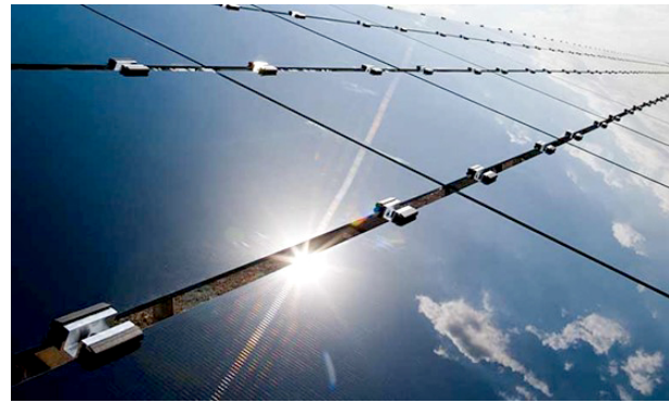
Рис. 5. Солнечные элементы на основе теллурида кадмия [23] Fig. 5. Solar cells based on cadmium telluride [23]
